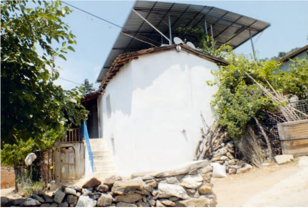
Gözpınar Mahallesi, Konut Mimarisinden Bir Örnek
