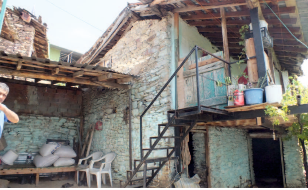
Gözpınar Mahallesi, Hüseyin Yetim Evi, Kuzeydoğu Cephesi
