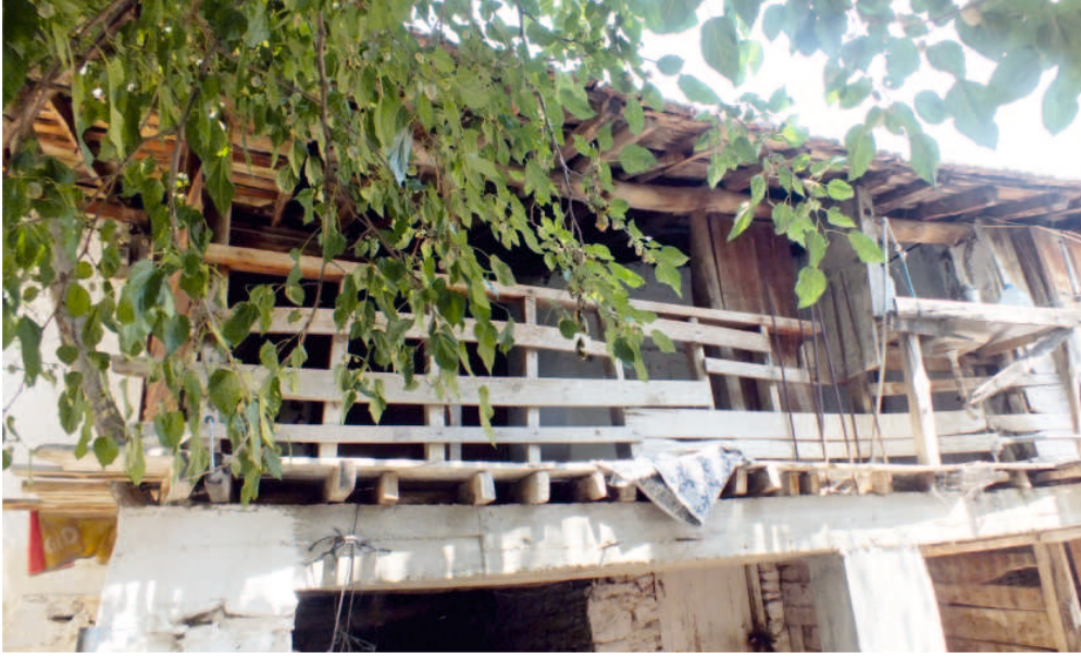
Gözpınar Mahallesi, Yusuf Acar Evi, Batı Cephesi
