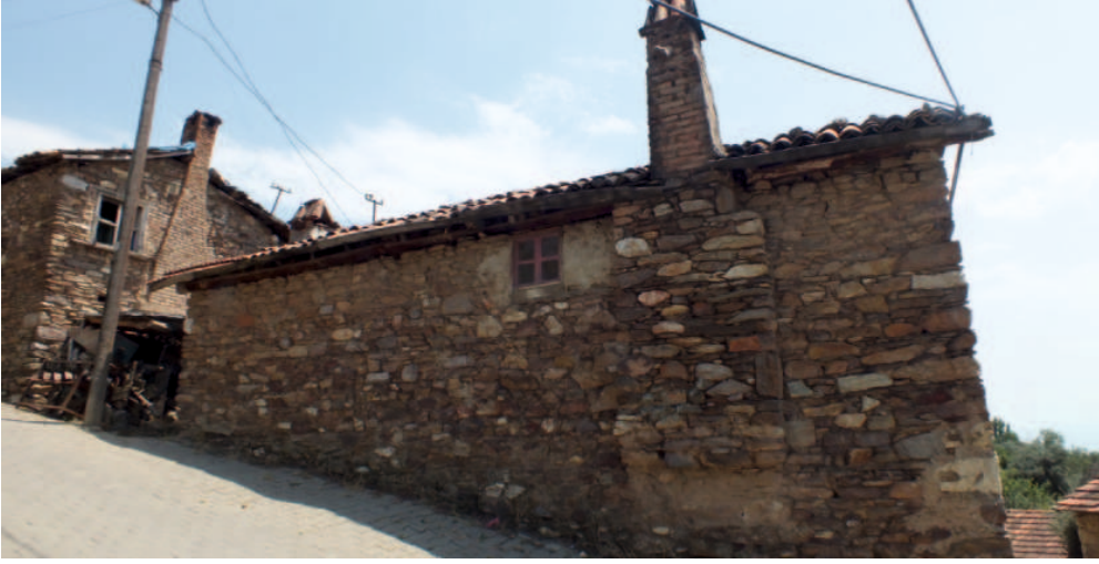
Gözpinar Mahallesi, Turgut Günay Evi, Kuzey Cephesi
