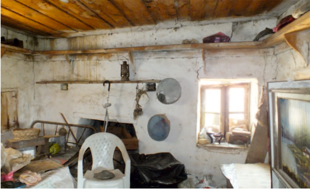
Gözpınar Mahallesi, Hasibe Acar Evi, Birinci Katta Güneydeki Odanın Güney Duvarı
