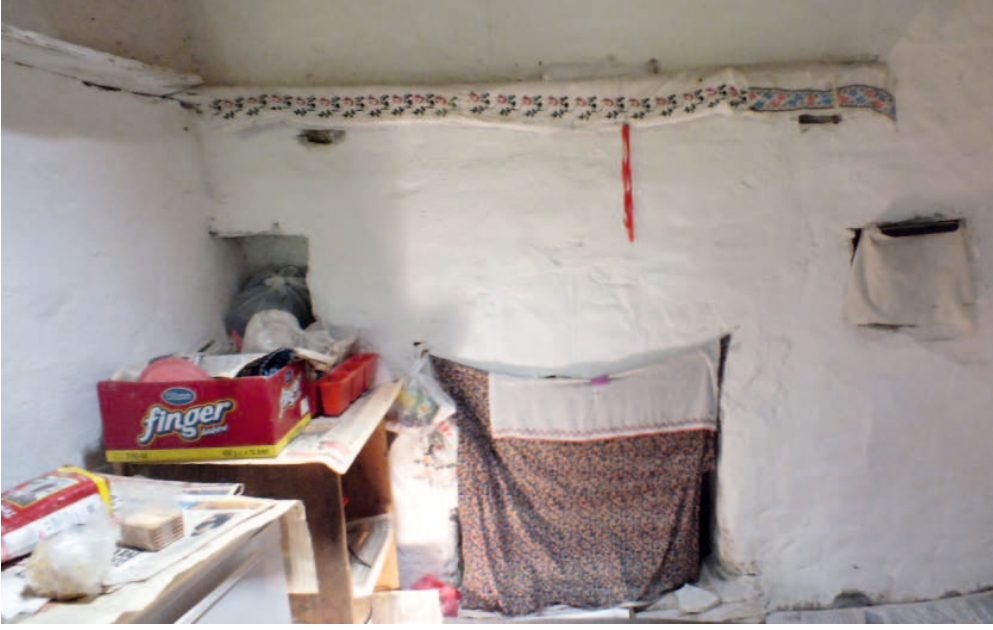
Gözpınar Mahallesi, Hasibe Acar Evi, Birinci Katta Ortadaki Odanın Doğu Duvarı
