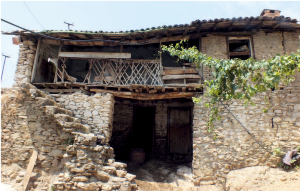
Gözpınar Mahallesi, Feyzullah Yavuz Evi, Güney Cephesi
