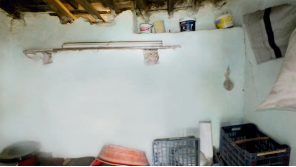
Gözpınar Mahallesi, Hüseyin Yetim Evi, Birinci Kat Kuzeydeki Odanın Doğu Duvarı
