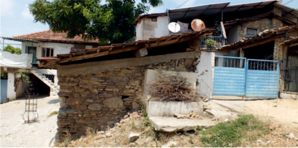
Gözpınar Mahallesi, Köy Odası'nın Güney Cephesi
