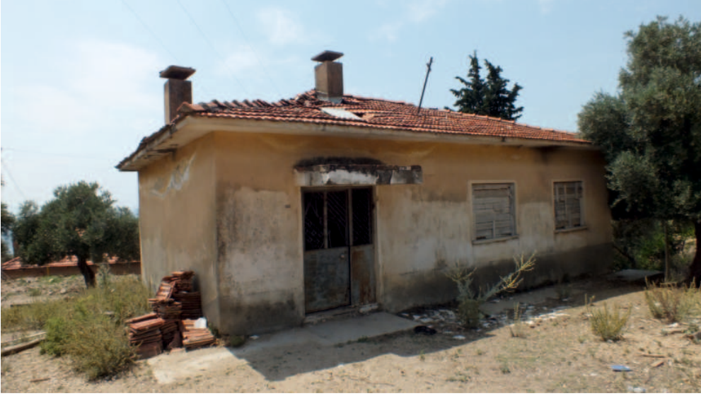
Gözpınar Mahallesi, Köy Okulu'nun Güneydoğu Cephesi
