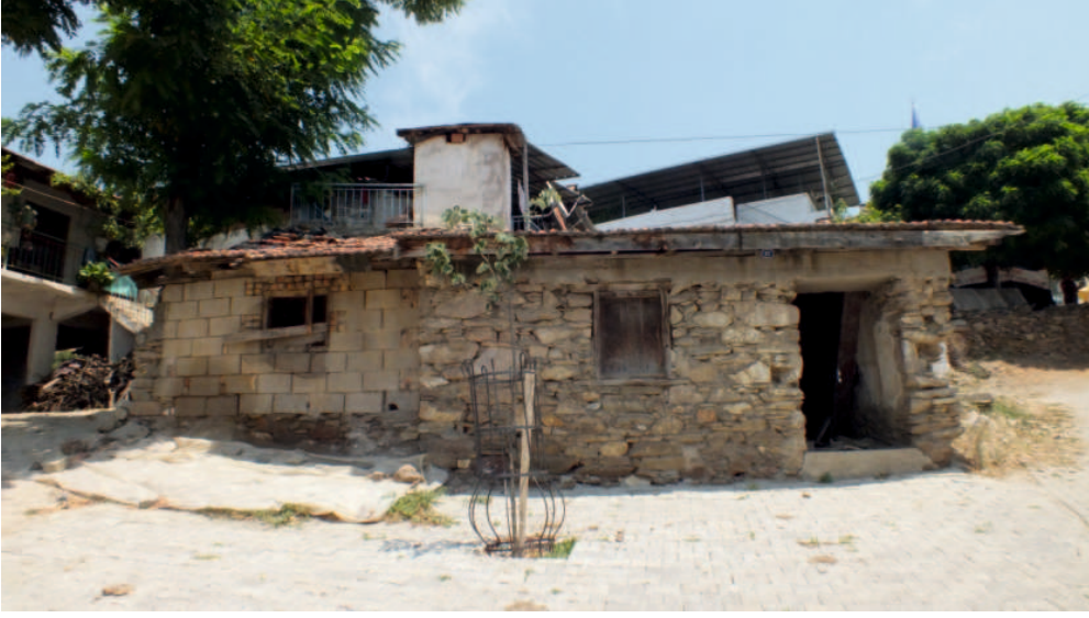
Gözpinar Mahallesi, Köy Odası'nın Batı Cephesi
