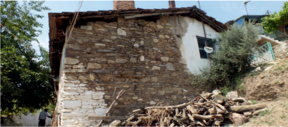
Gözpınar Mahallesi, Hüseyin Yetim Evi, Güney Cephesi
