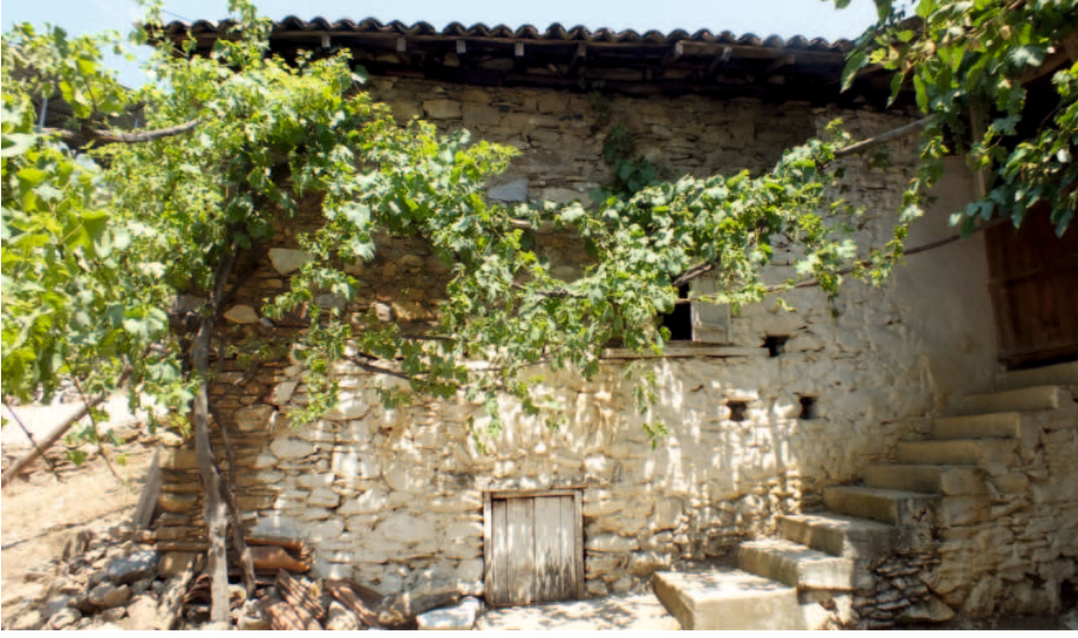
Gözpınar Mahallesi, Yusuf Acar Evi, Batı Cephesi
