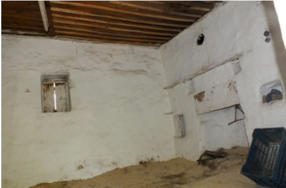
Gözpınar Mahallesi, Yusuf Acar Evi, Birinci Kat Kuzeydeki Odanın Güneydoğusu
