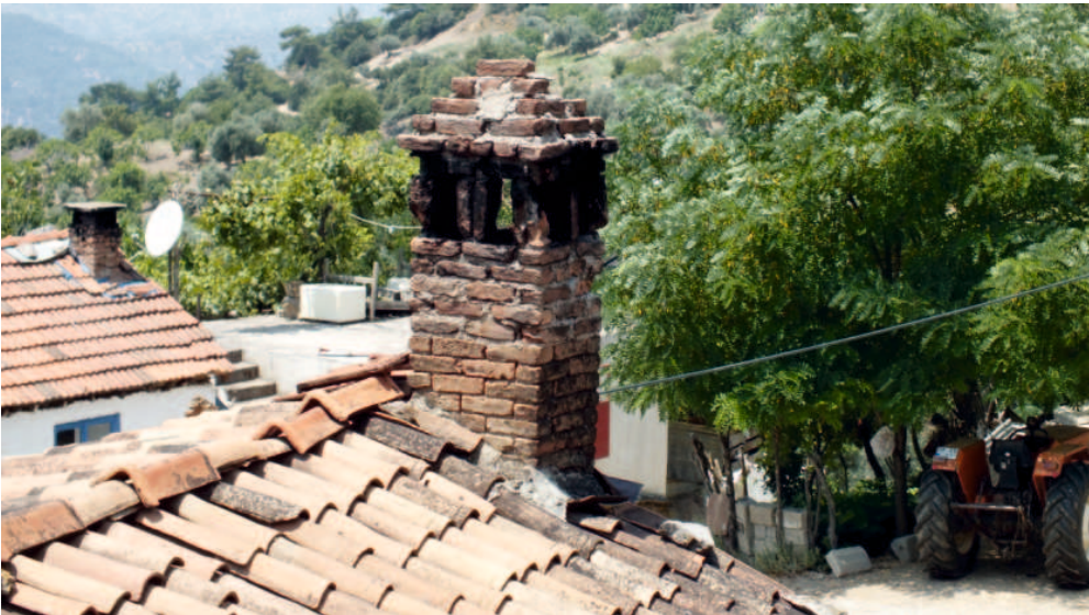
Gözpinar Mahallesi, Hasibe Acar Evi, Çatı Sistemi
