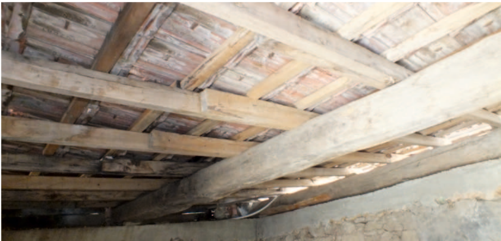
Gözpınar Mahallesi, Köy Odası'nın İçten Örtü Sistemi
