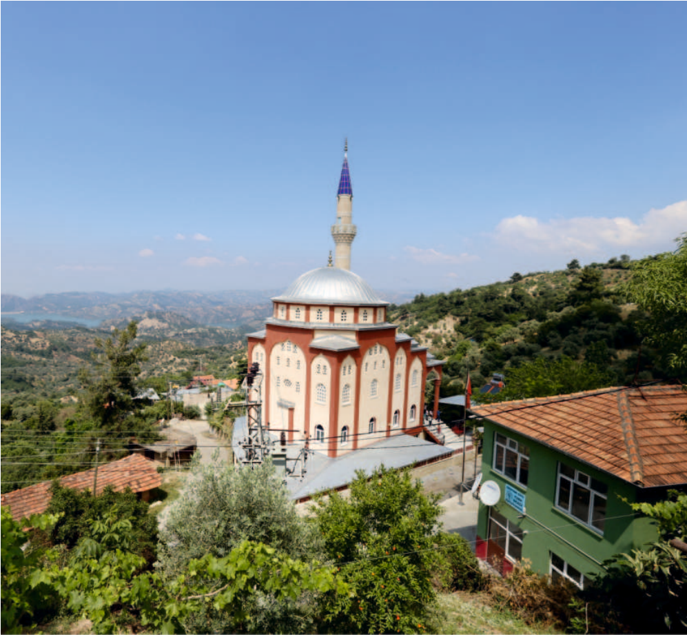
Gözpınar Mahallesi, Camiin Güneydoğu Cephesi
