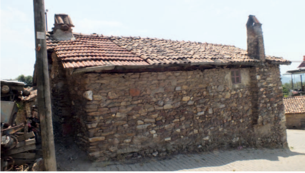
Gözpınar Mahallesi, Feyzullah Yavuz Evi, Kuzeydoğu Cephesi
