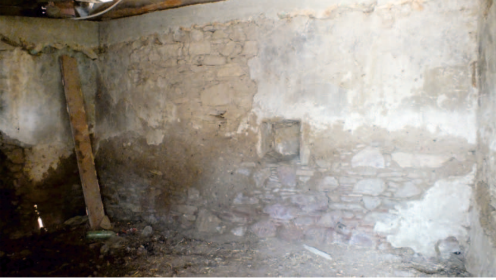
Gözpınar Mahallesi, Köy Odası'nın İçten Kuzeydoğu Duvarı
