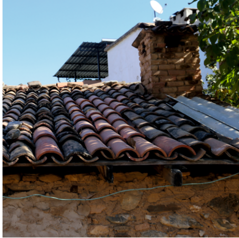
Danişment Mahallesi, Bayram Özdemir Evi, Çatı Sistemi
