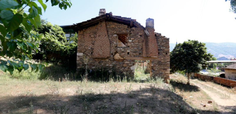
Danışment Mahallesi, Ahmet Bircan Evi, Kuzey Cephesinden Bir Görünüm
