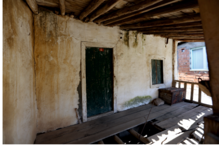
Danişment Mahallesi, Necati Yufun Evi, Birinci Kat Sofasına Açılan Kapı ve Pencere
