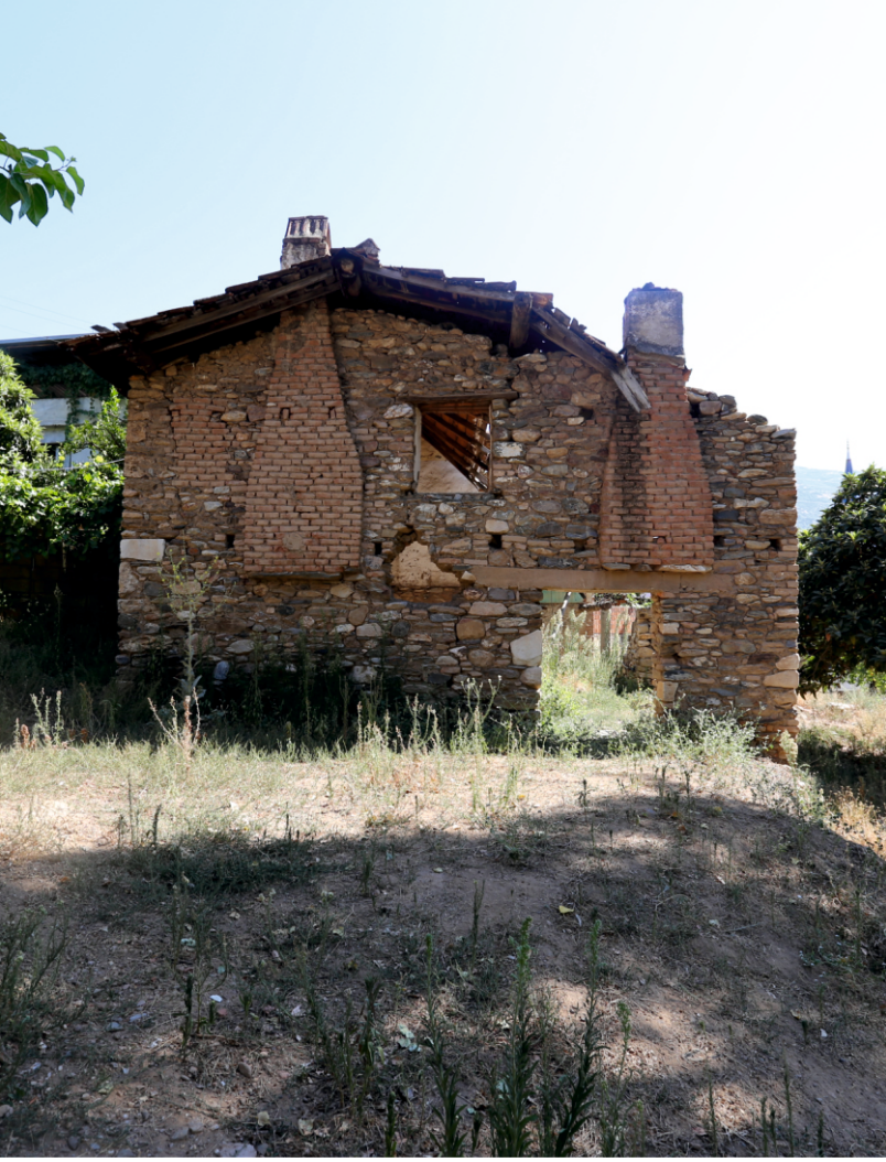
Danişment Mahallesi, Ahmet Bircan Evi, Kuzey Cephesi
