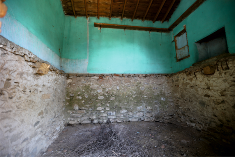
Danişment Mahallesi, Ahmet Bircan Evi, Birinci Katta Ortadaki Odanın Doğu Duvarı
