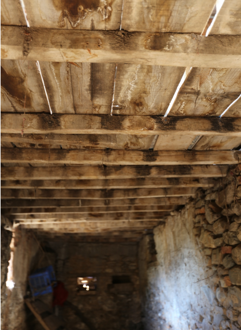
Danişment Mahallesi, Bekir Yufun Evi, Zemin Katın Güneyindeki Mekân
